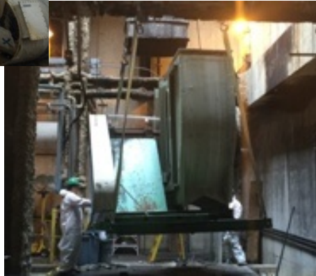
Odor Control Fan Removal
